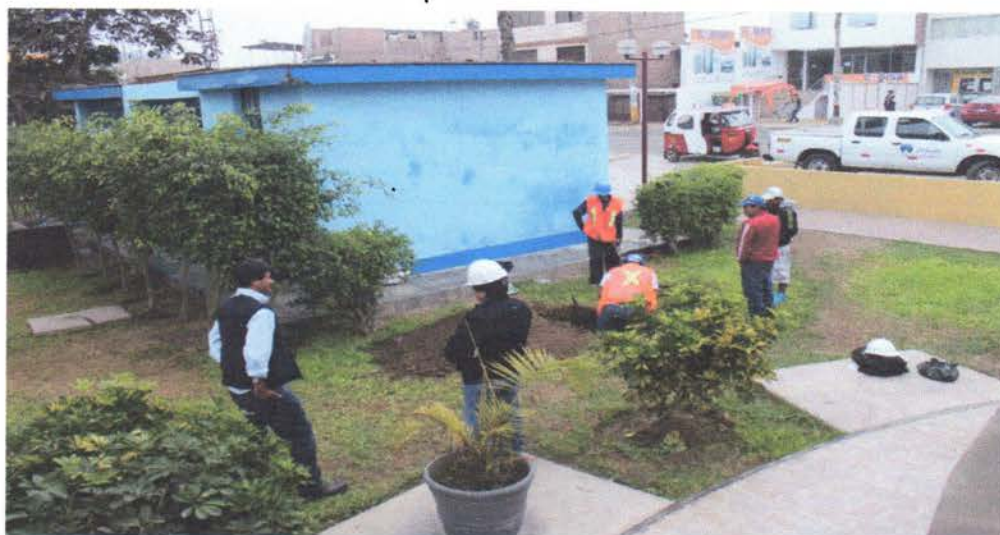
Fotografía N° 01: Excavación de calicata N° 01
