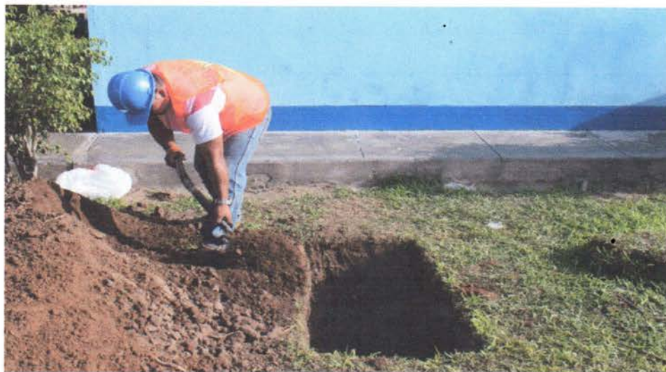
Fotografía N° 02: Calicata N° 01 a profundidad de 2.50 m
